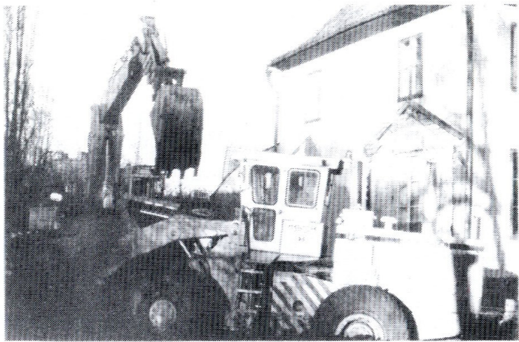
Byggarbetet har börjat
